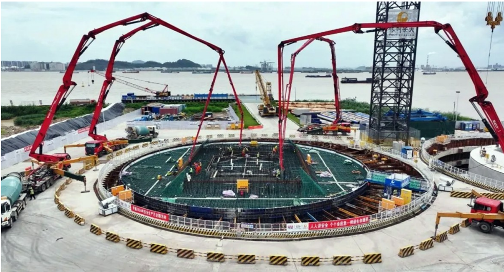
■狮子洋大桥东索塔右幅承台最后一层浇筑完成
